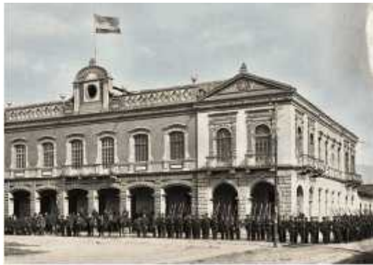
Figura 11-2: Edificio de la Gobernación, 1900 Fuente: (Diario Regional Los Andes, 2020)
