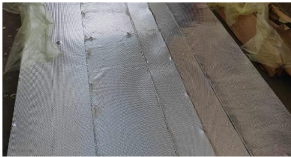
Figura 3-3. Pared colocada la chova alumband sobre el tol galvanizado
