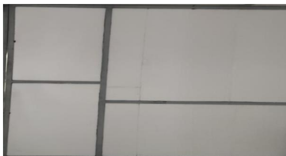
Figura 4-3. Pared colocada espuma flex sobre el tol galvanizado
