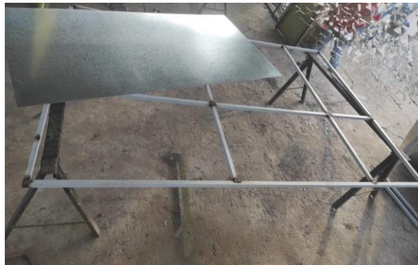
Figura 1-3. Estructura metálica soldada
