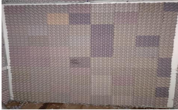
Figura 5-3. Pared colocada cubetas de huevos sobre la espuma flex
