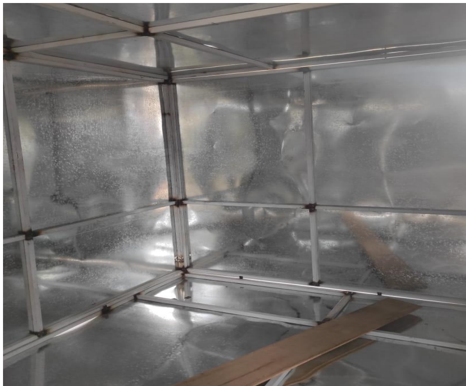
Estructura metálica interna de la caja.
