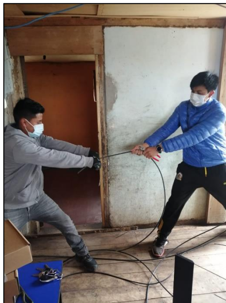
Figura 17-3: Preparación de la fibra óptica de 48 hilos para insertar en la OLT.
