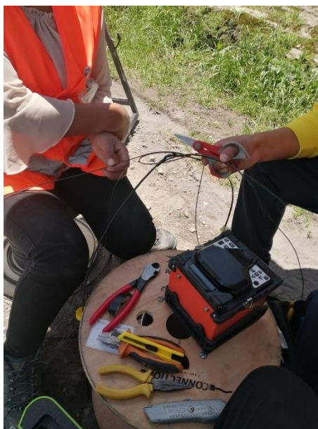
Figura 21-3: Fusión de hilos.
