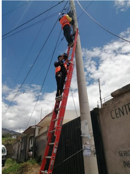
Figura 19-3: Tendido de FO del último tramo de la red 1FD3 y la
