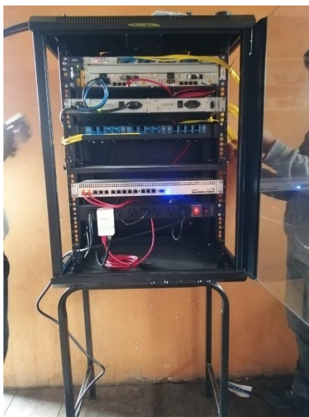
Figura 18-3: OLT-Quimiag, implementada y en funcionamiento.
