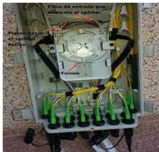
Figura 8-2: Conexión de divisor óptico de segundo nivel.
