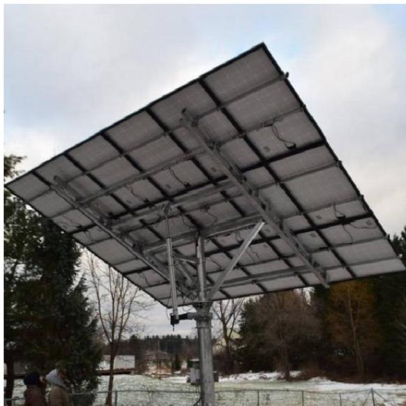
**Ilustración 2-6:** Seguidor solar de un Solo eje
