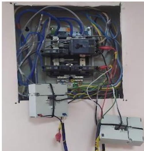
**Ilustración 3-3:** Conexión del módulo PM800
