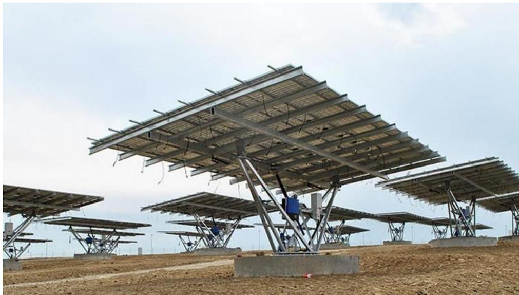
**Ilustración 2-7:** Seguidor Solar de dos ejes
