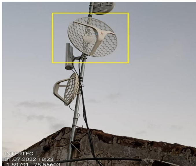
Ilustración 90-3: Colocación del BH-GLL_RAY en el nodo Guarguallá.
