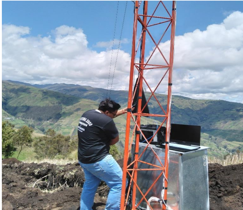
Ilustración 24-3: Barrido de frecuencia con el analizador de espectros Deviser E8600B en el nodo Rayoloma.
