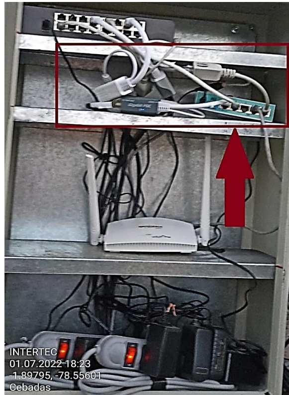
Ilustración 89-3: Identificación del puerto y conexión del BH-GLL_RAY.
