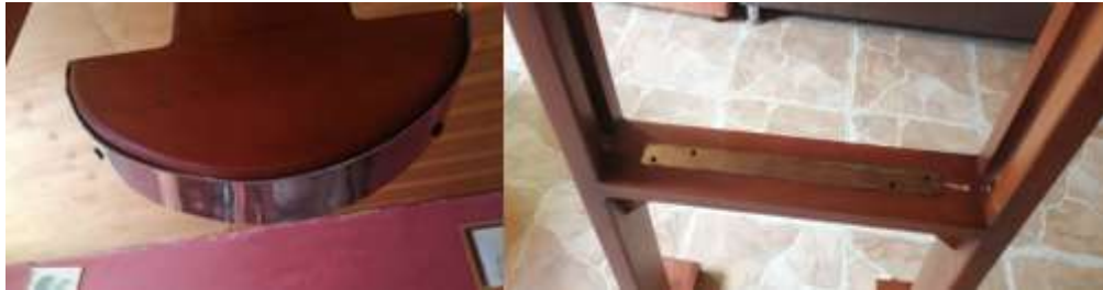
Ilustración 3-8: Implementación de Platina en la parte cóncava y en la base.
