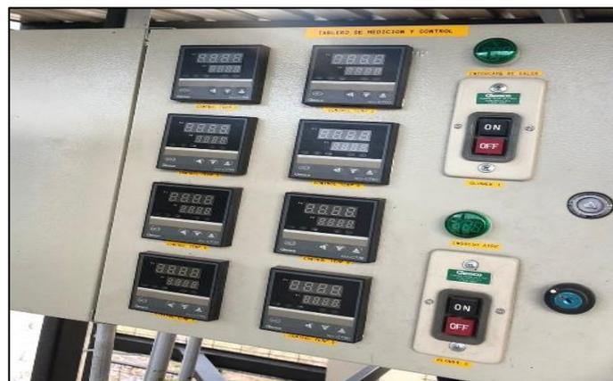
**Ilustración 3-5:** Tablero de control del gasificador downdraft
