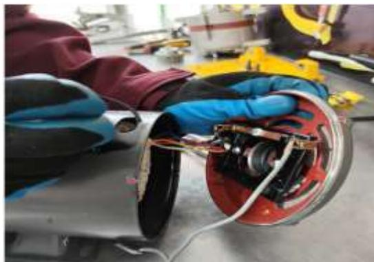
**Ilustración 15:** desconexión de cables de la tapa del motor.
