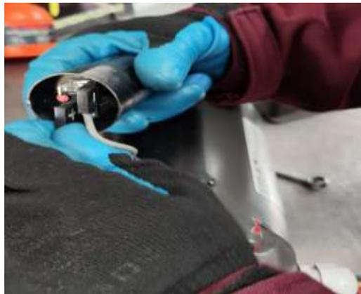
**Ilustración 14:** Conexiones del condensador
