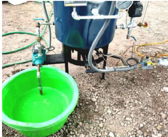
Ilustración 3-41: Verificación de funcionamiento de bomba de agua Realizado por: Colcha F., Tonato J., 2023.
