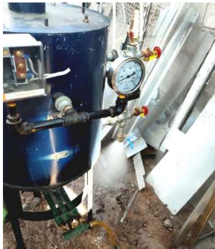
Ilustración 3-38: Vaciado del hogar del caldero
