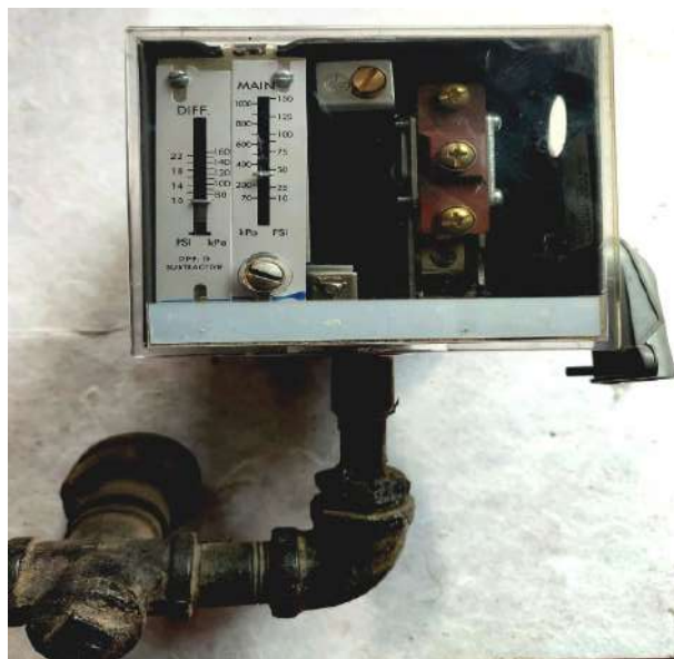
Ilustración 3-18: Pressuretrol
