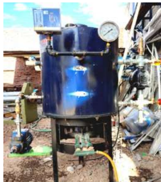
Ilustración 3-35: Preparación del caldero
