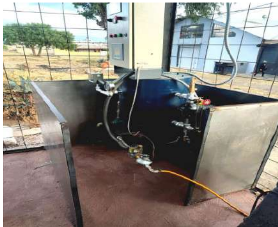
Ilustración 3-50: Instalación de carama de protección del caldero
