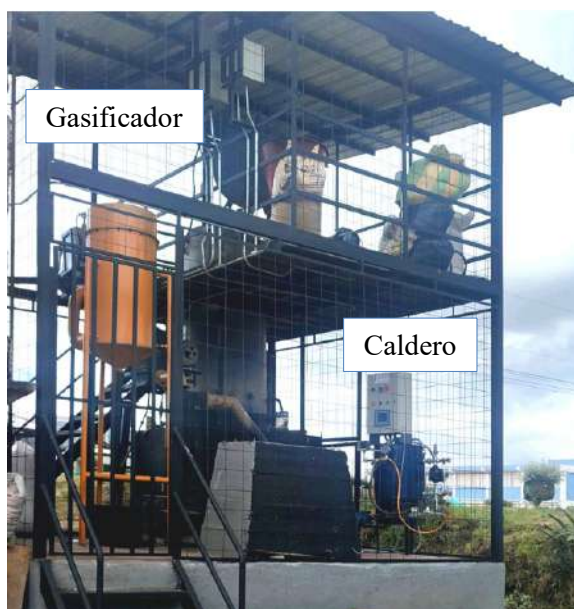
Ilustración 3-48: Ubicación del caldero junto al Gasificador
