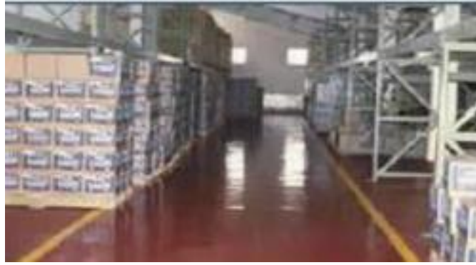
Ilustración 3-2: Pisos adecuados en el área de bodega.
