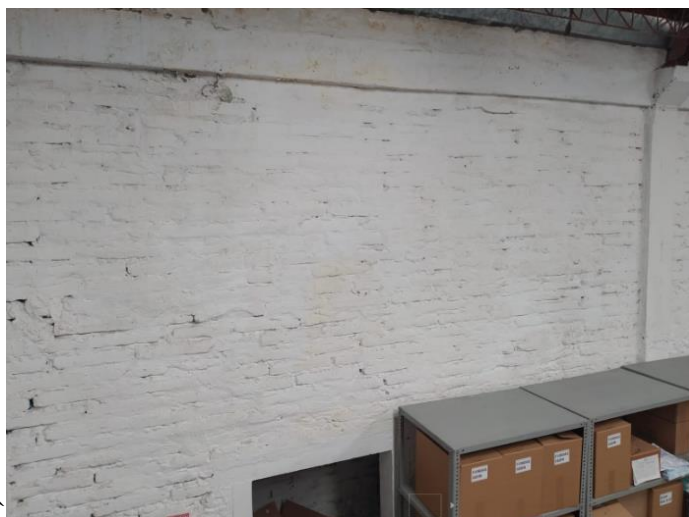
Ilustración 4-4: Paredes del área de bodega.
