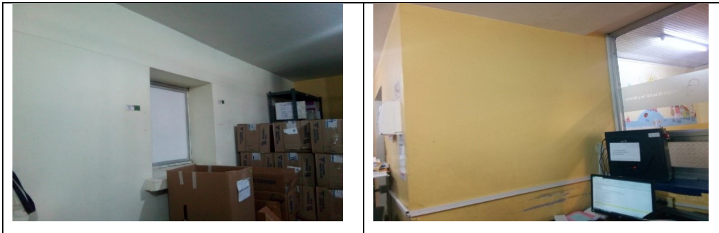
Ilustración 4-4: Falta de rótulos de recepción, almacenamiento y distribución
