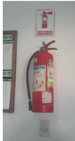
Reubicación del extintor de incendios y señalética de seguridad
