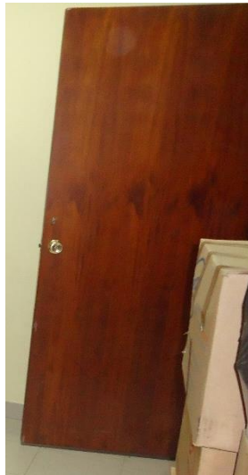
Bodega sin señalética que impida el ingreso
