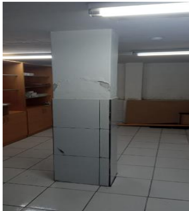
Ilustración 4-19: Pisos y paredes lisas
