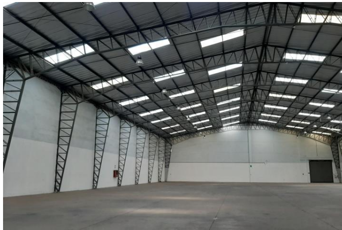
Ilustración 2-4: Techos y paredes del área de bodega
