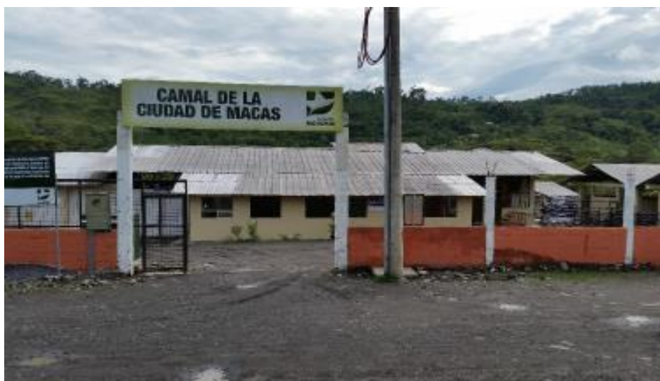
Ilustración 2-1: Foto Camal municipal de Macas.
