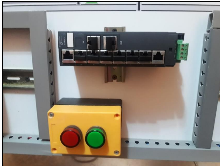
Figura 10-2: Colocación de bases para fijación de Distribuidor Modbus
