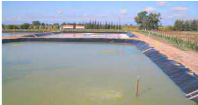
**Ilustración 2-4:** Laguna de oxidación (estabilización)
