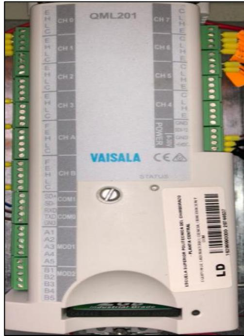
**Figura 5-3:** Registrador de datos VAISALA QML 201C.
