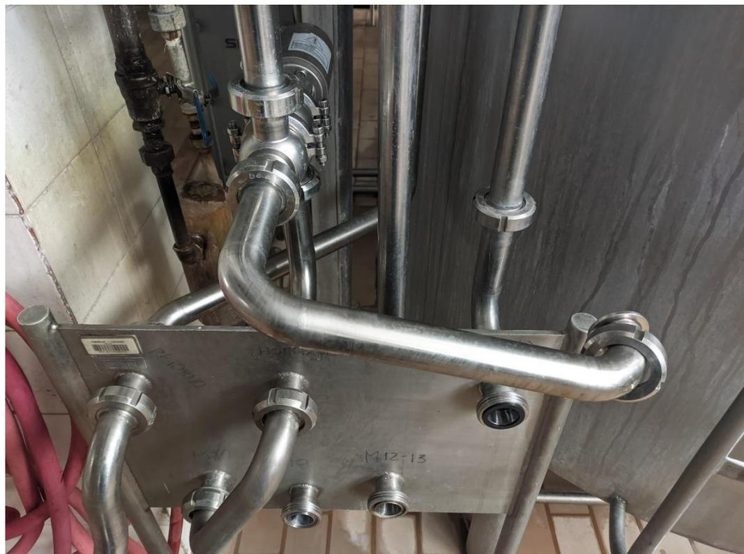
**Figura 16-3.** Después de incorporar la válvula de tres vías
