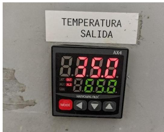
**Figura 12-3.** Colocación en la puerta del tablero del controlador de temperatura
