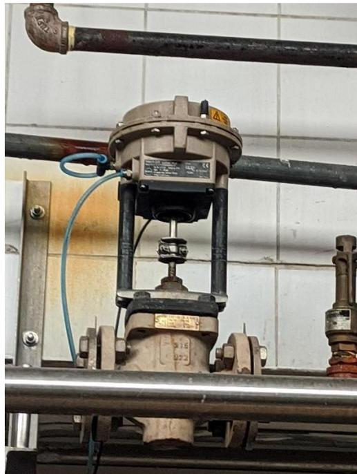
**Figura 17-3.** Electroválvula neumática proporcional Samson
