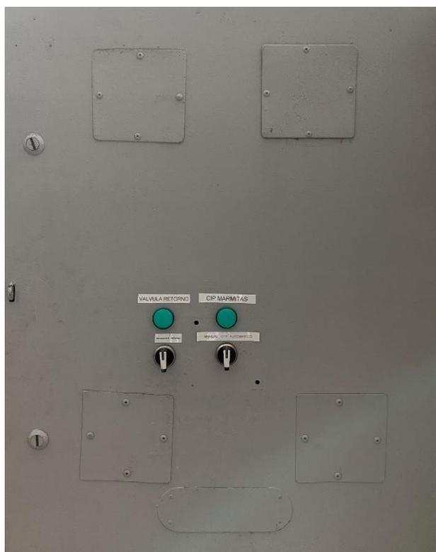
**Figura 14-3.** Luces piloto de identificación de electroválvulas
