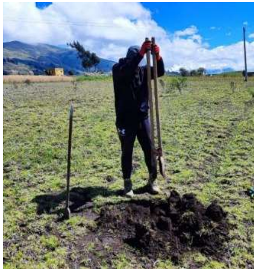
Ilustración 1-10: Perforación del suelo
