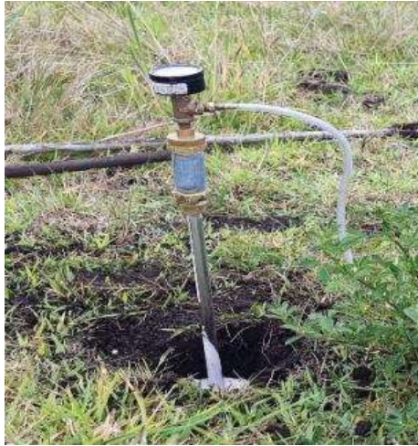
Ilustración 3-5: Colocación de yeso
