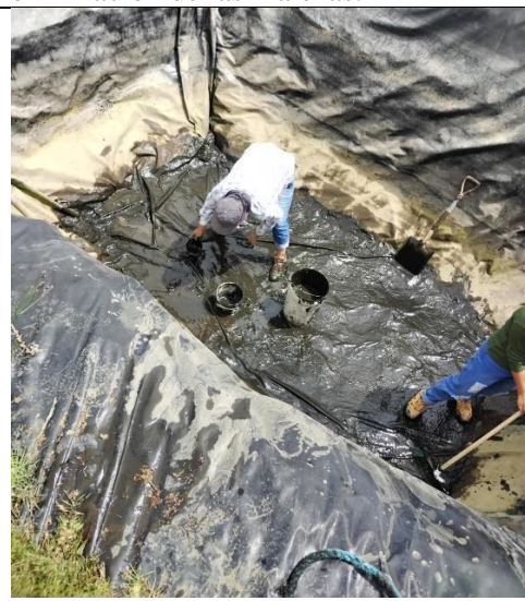
Mantenimiento del reservorio
