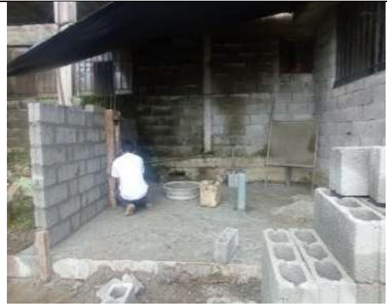
Construcción de la pared
