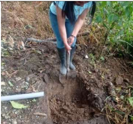
Excavación de la caja de salida de biol
