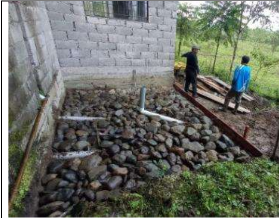
Construcción de la plancha de cemento
