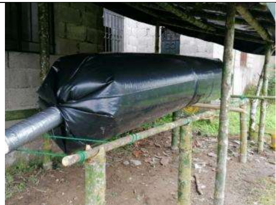
Construcción del gasómetro
