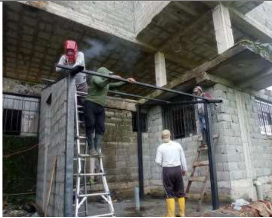
Construcción de la estructura metálica
