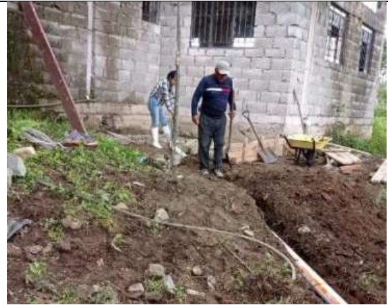
Instalación de tubería de salida de sólidos
