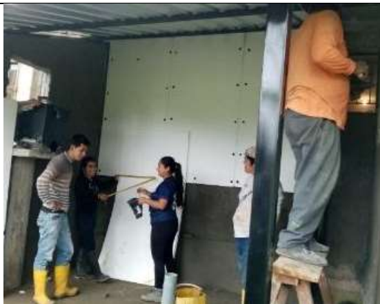
Colocación de la espumaflex
