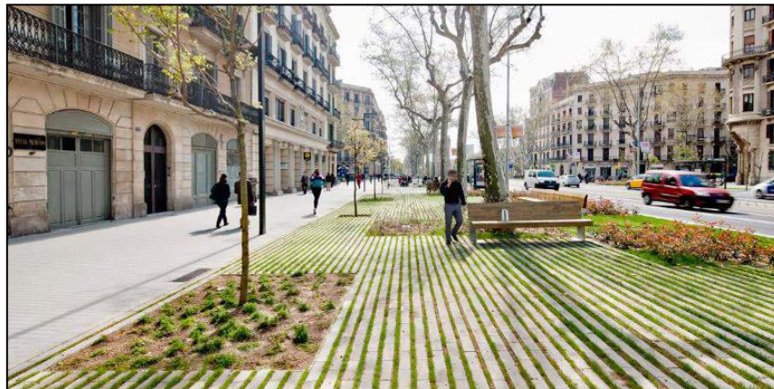
Ilustración 17-2: Superficie de césped reforzada en Barcelona.
