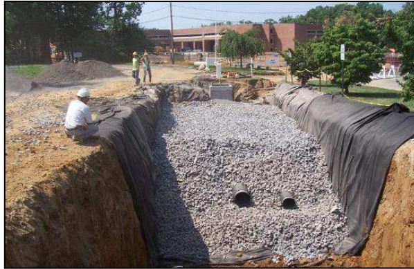
Ilustración 13-2: Zanja de infiltración profunda.
