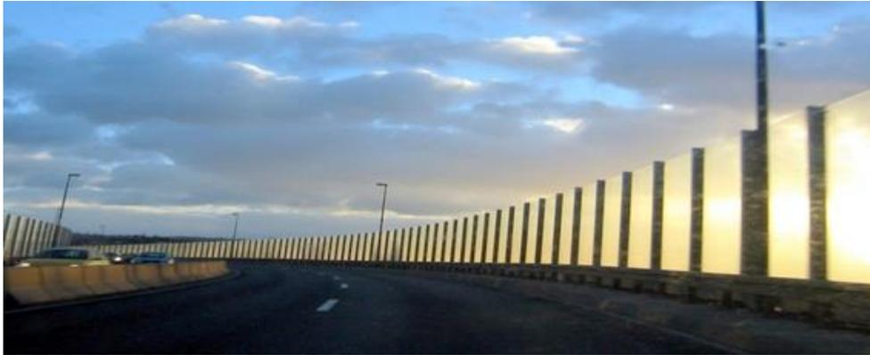
**Figura 5-2:** Barreras acústicas para evitar propagación de ruidos molestos
