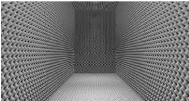
**Figura 6-2:** Aislamiento acústico para evitar exposición a ruidos molestos
