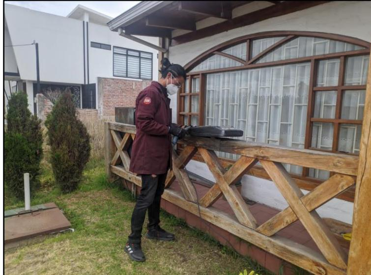
**Ilustración 3-41:** Corte de excesos en la pieza final
