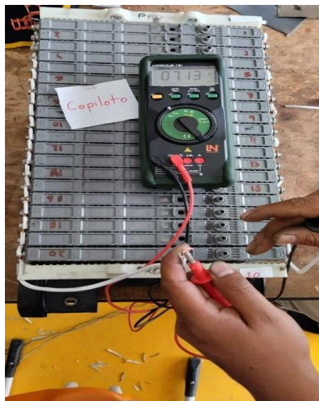
Ilustración 3-17: Medición individual de voltaje de los módulos
