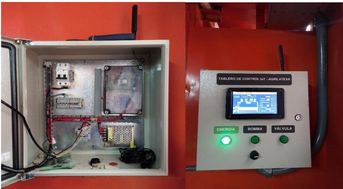
**Figura 39-3:** Tablero de control del Sistema Automatizado.
