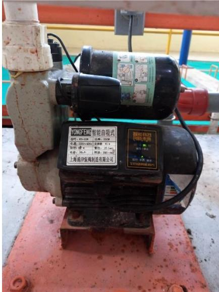
**Figura 28-3:** Bomba hidráulica 1HP
