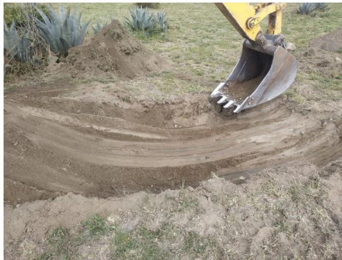
Ilustración 4-15: Construcción de rompe-ejes.
