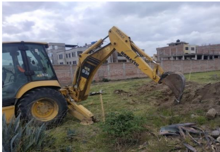
Ilustración 2-10: Retroexcavadora WB 93 Komatsu
