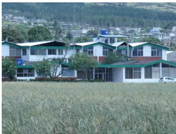
FOTOGRAFÍA No. 7 DEPARTAMENTO DE NUTRICIÓN Y CALIDAD (INIAP)
