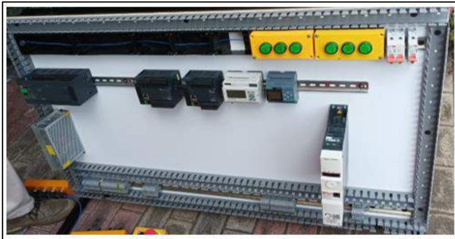
**Ilustración 32-3:** Montaje de Termomagnéticos PLCs, ATV y Fuente de Poder
