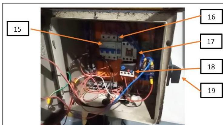
**Figura 34-3:** Gabinete de control arranque directo del motor
