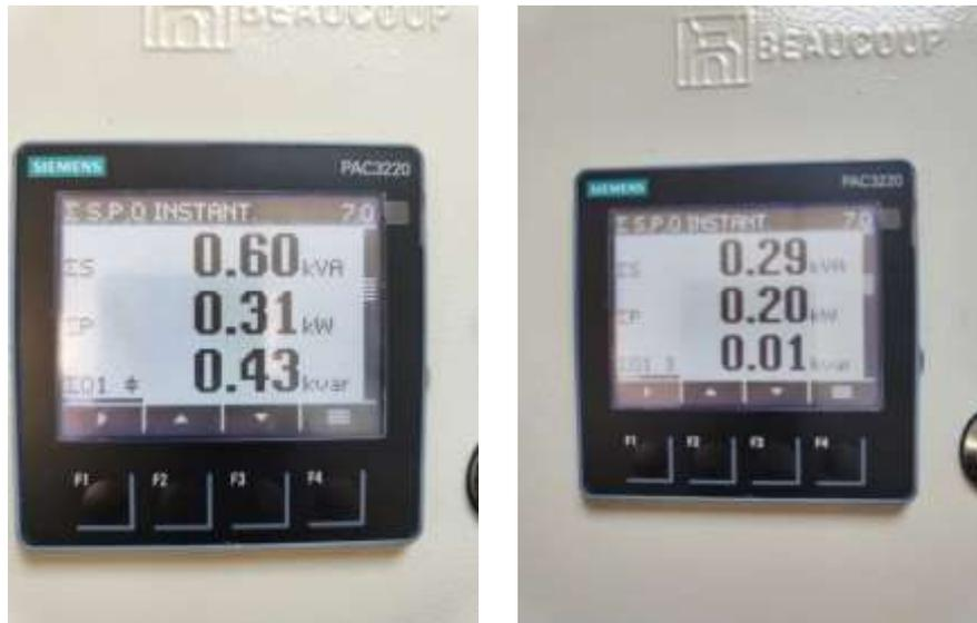
**Figura 3-4.** a) Medición de potencia UPS encendido. b) Medición con el UPS apagado.
