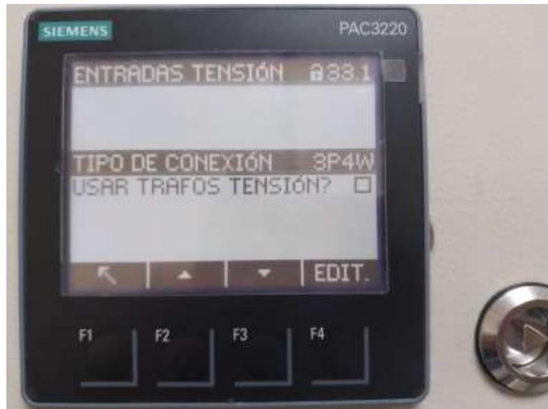
**Figura 12-3.** Entradas de Tensión del Medidor de Energía.
