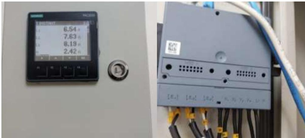
**Figura 6-3.** Instalación del Medidor de Energía SENTRON PAC3220.
