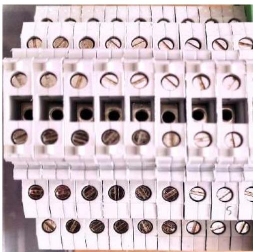
**Ilustración 15-3:** Borneras de conexión.
