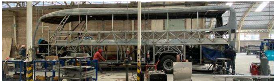
Ilustración 3-7: Área de ensamble en la planta de MEGABUUSS CIA. LTDA.
