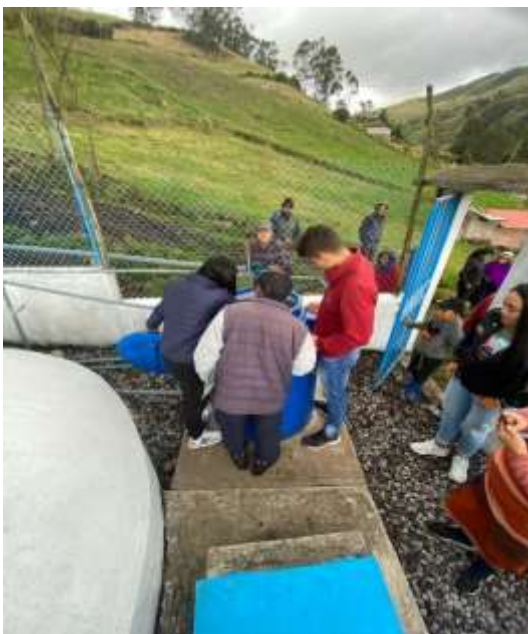
Indicaciones a la comunidad del funcionamiento del tanque de filtración
