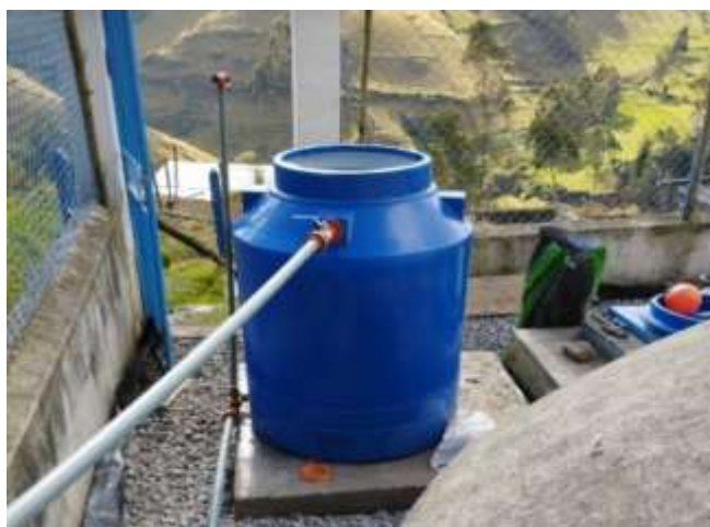
Ilustración 3-17: Tanque utilizado para la instalación del filtro
