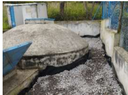
Adecuación del tanque de almacenamiento
