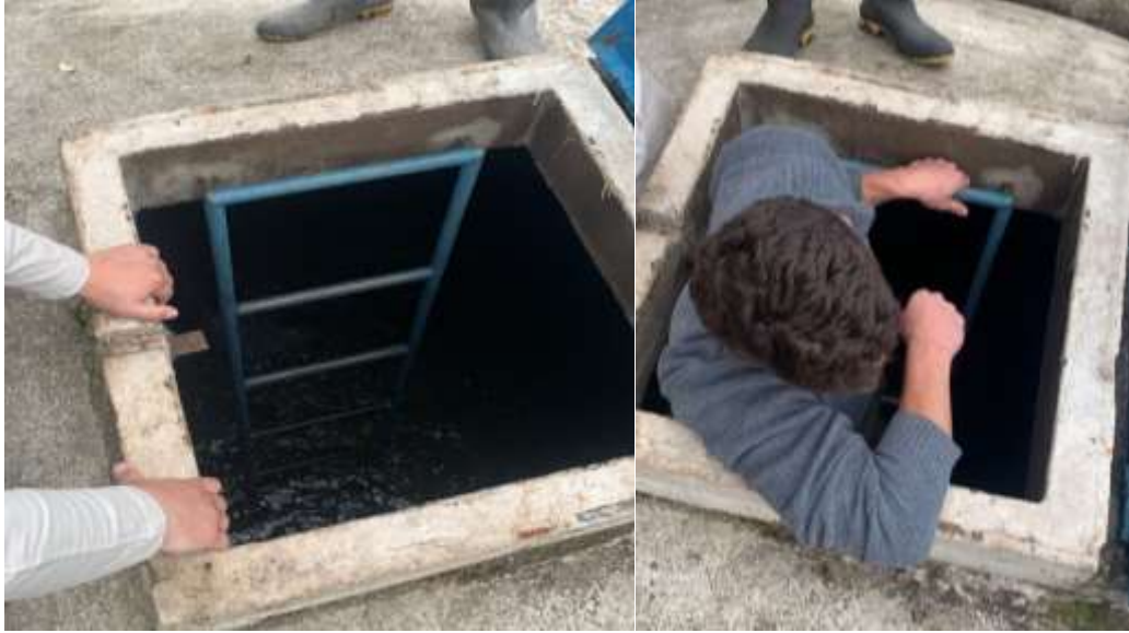
Ilustración 3-11: Inspección del tanque de almacenamiento de agua para la comunidad
