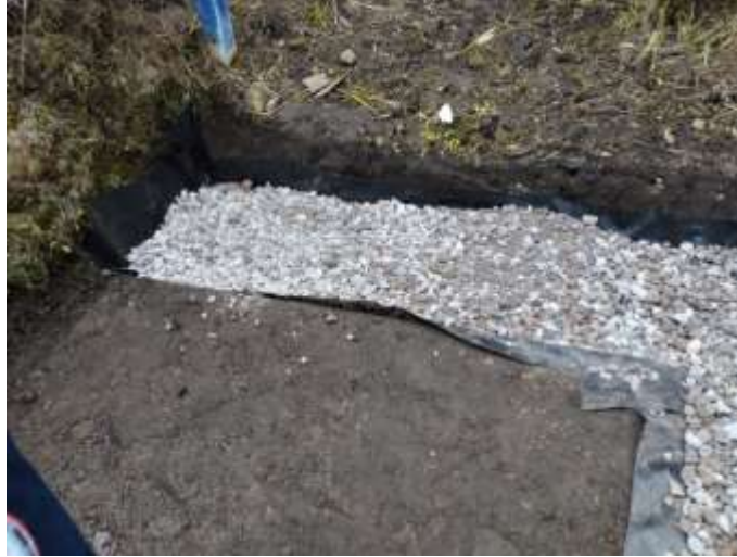
Ilustración 3-14: Colocación de capa de lastre
