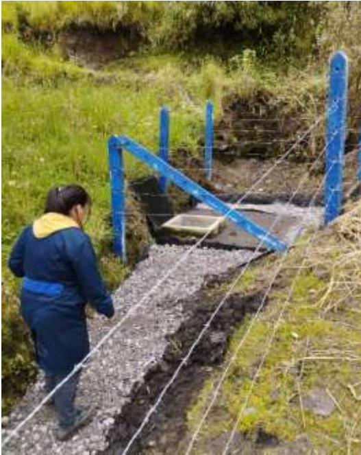
Verificación de la colocación de grava en la captación
