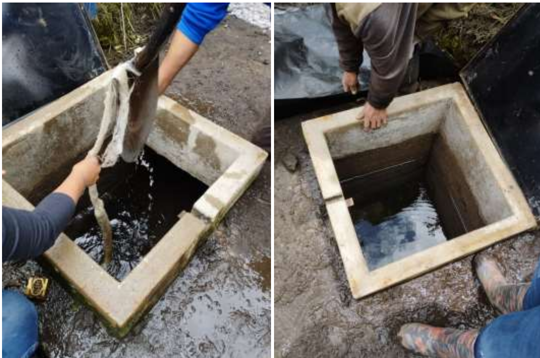
Ilustración 3-13: Limpieza de la fuente de agua
