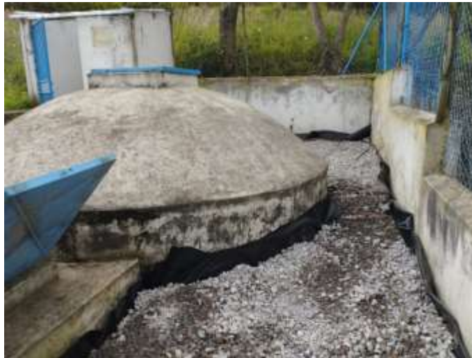
Ilustración 3-15: Protección contra la infiltración.
