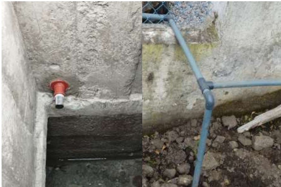
Ilustración 3-24: Colocación tubería PVC para la conducción de agua
