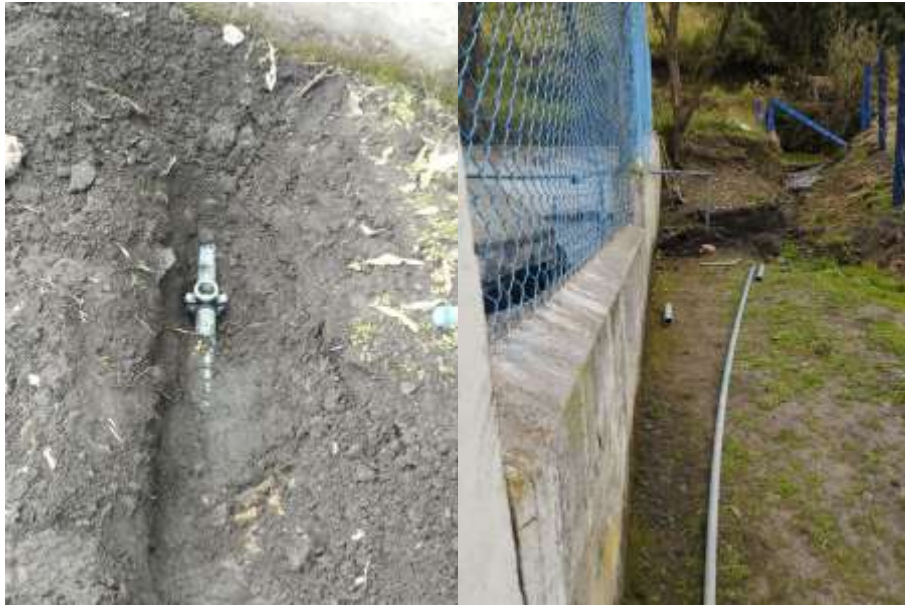
Ilustración 3-22: Colocación de collarín PVC
