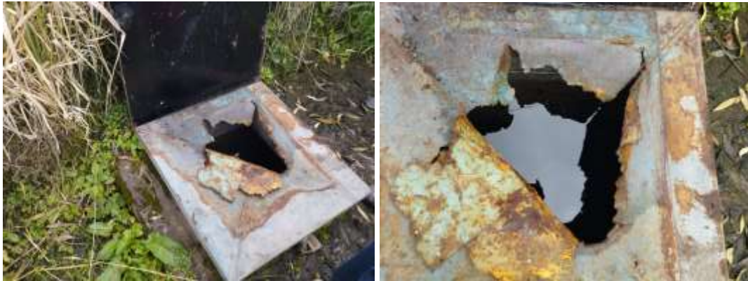
Ilustración 3-2: Captación de agua
