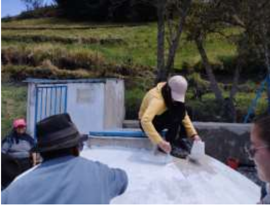
Colocación de una capa de pintura de protección al tanque de almacenamiento
