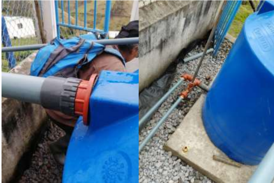
Ilustración 3-25: Colocación tubería PVC para la conducción de agua
