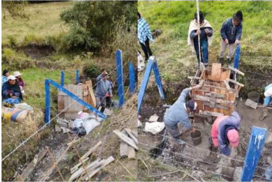
Ilustración 3-23: Aumento de la capacidad del tanque de captación de la vertiente 1
