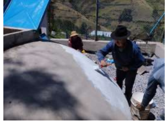
Colocación de una capa de pintura de protección al tanque de almacenamiento
