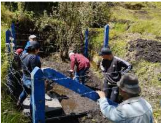
Control y limpieza del tanque de captación
