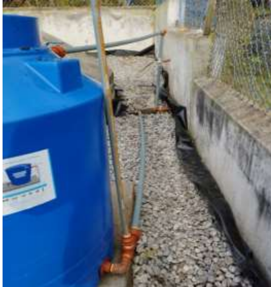
Ilustración 3-18: Colocación tubería PVC para la conducción de agua
