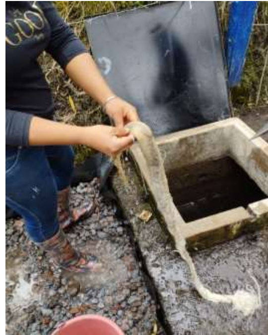
Limpieza de sedimentos en la captación
