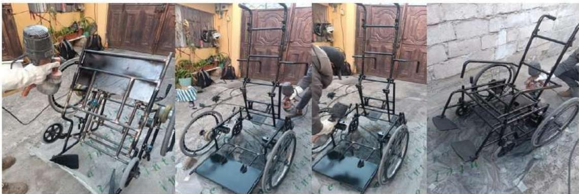
**Ilustración 3-31:** Pintado de la parte estructural del prototipo
