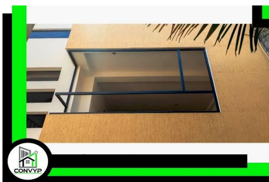
Ilustración 5-4: Instalación de vidrio templado en Quinta Los Juanes
