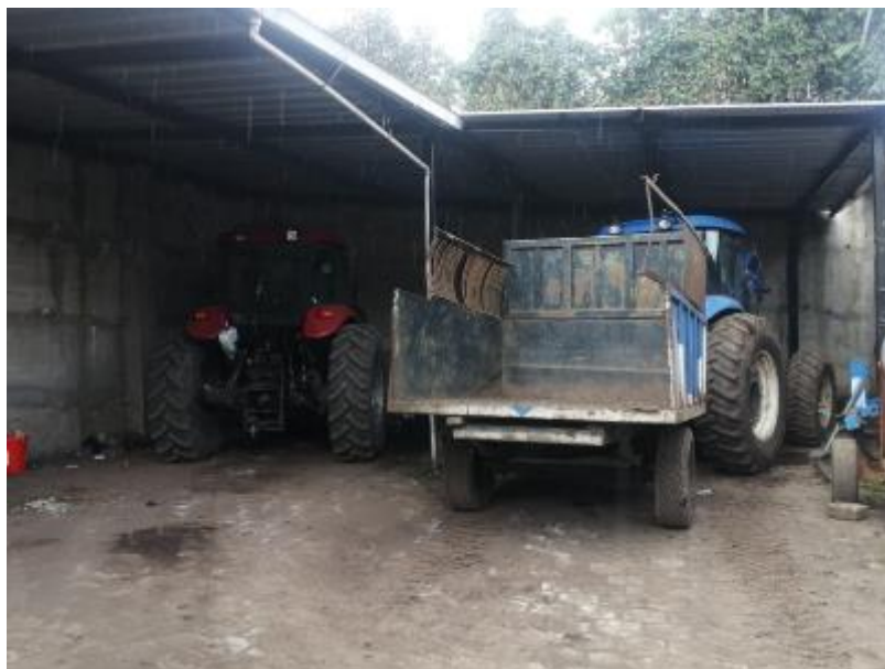
Ilustración 4-2: Patio de Máquinas de la parroquia La Candelaria
