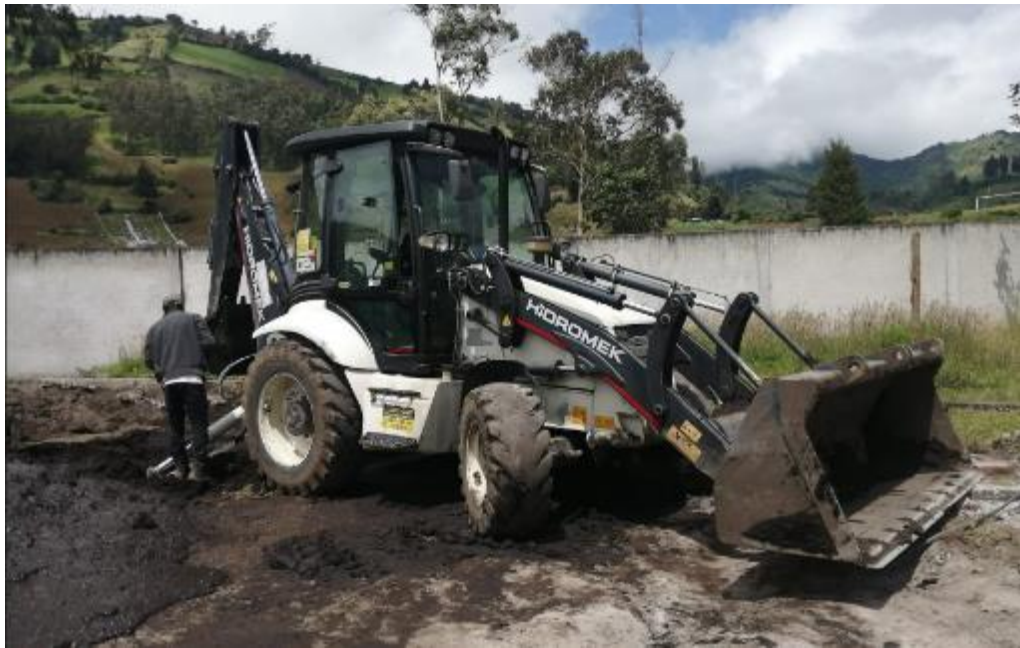
Ilustración 4-24: Retroexcavadora Hidromek 102B
