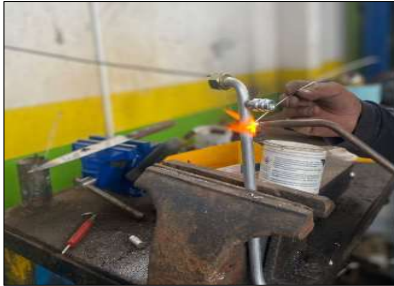
Ilustración 3-17: Soldadura de acoples para alta y baja presión
