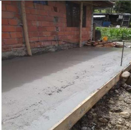
Vaciado de concreto en el piso.
