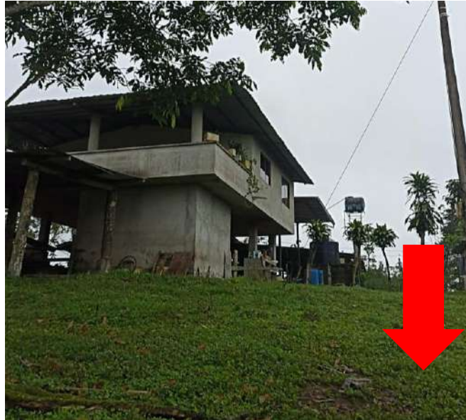
Ilustraciones 2-3: Área donde se construyó el biodigestor.
