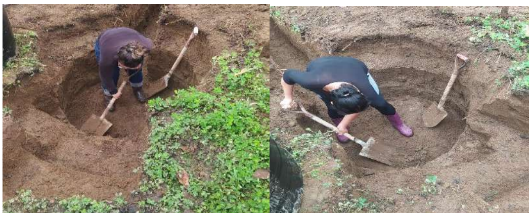
Ilustraciones 2-6: Excavación del biodigestor, zanjas de entrada y salida
