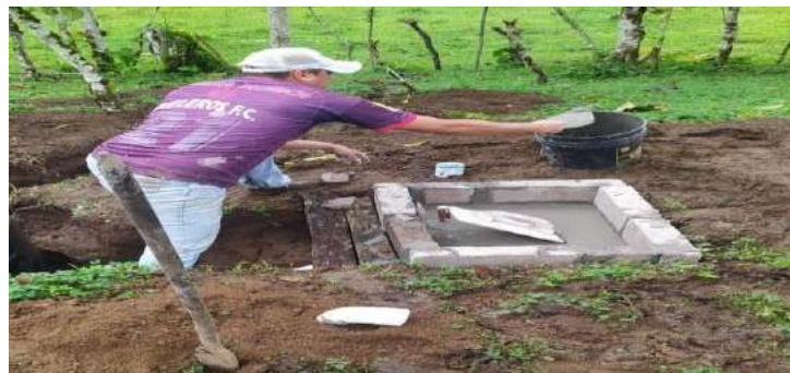
Ilustraciones 2-8: Construcción de la caja de salida del biol
