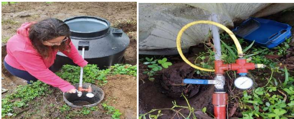
Ilustraciones 2-12: Construcción e instalación de la tubería de biogás.
