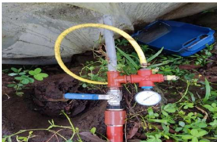
Ilustraciones 2-10: Construcción de la válvula de escape de gas.
