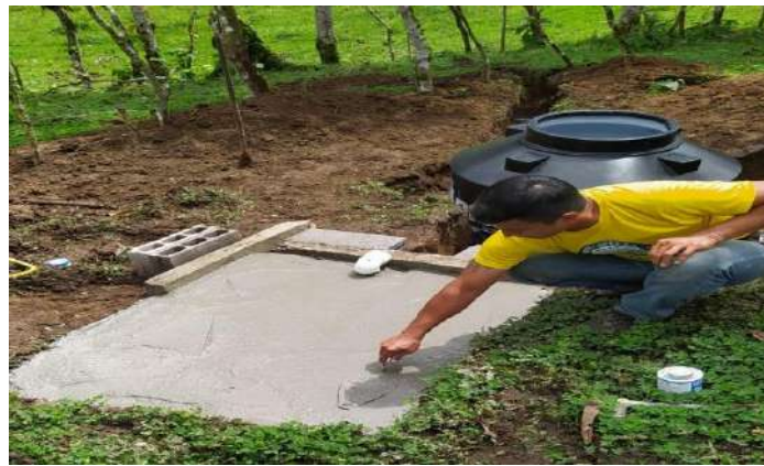
Ilustraciones 2-7: Construcción de la caja de alimentación.
