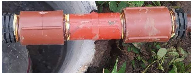
Ilustraciones 2-11: Construcción del filtro para ácido sulfhídrico
