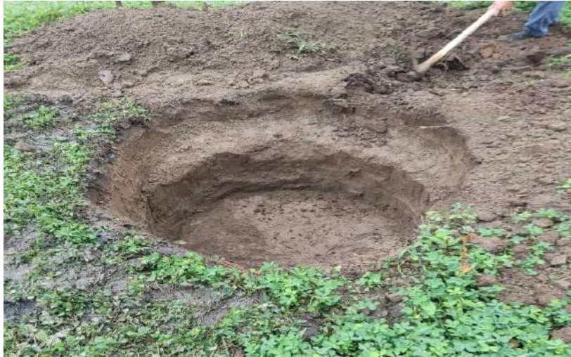
Ilustraciones 2-5: Marcación del lugar donde se construyó el biodigestor
