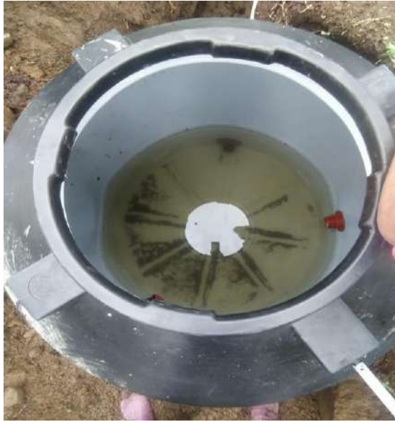
Ilustraciones 2-14: Limpieza del biodigestor.
