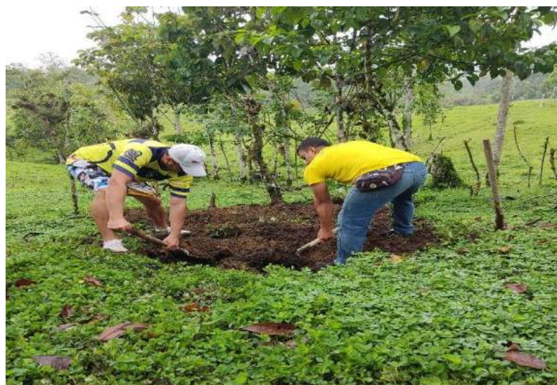
Ilustraciones 2-4: Limpieza del área donde se construyó el biodigestor
