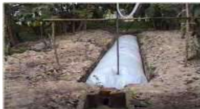
Ilustraciones 1-4: Diseño de un biodigestor horizontal
