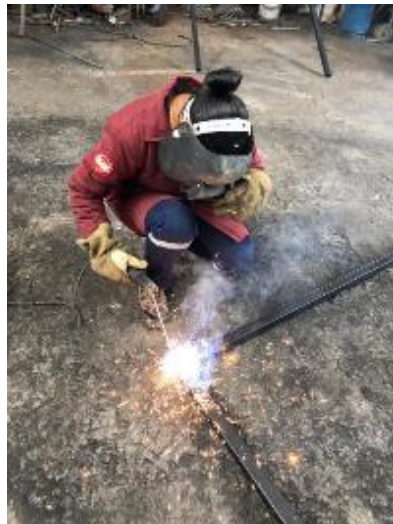
Ilustración 3-31: Soldadura de la estructura metálica
