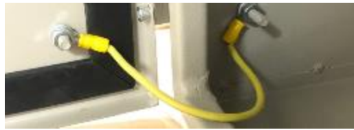
Ilustración 2-7: Puesta a tierra en un tablero principal
