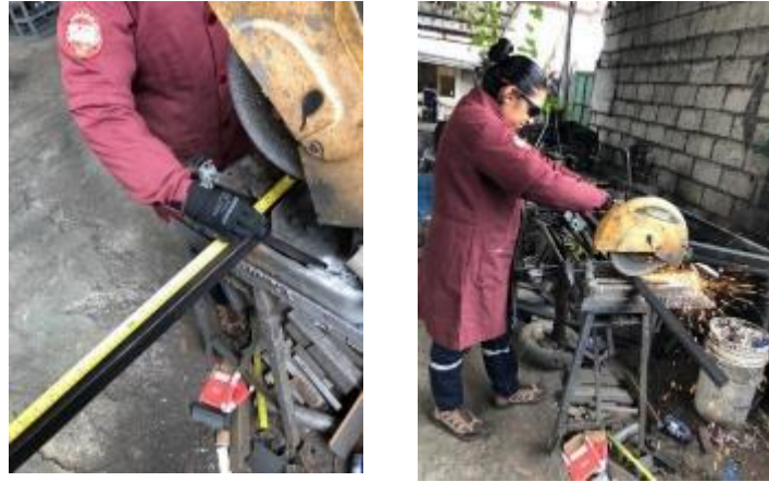
Ilustración 3-30: Medición y corte de cada pieza estructural
