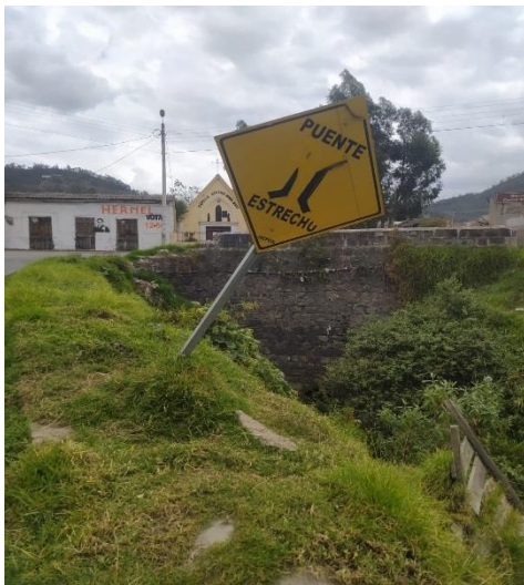
Señal de puente estrecho
