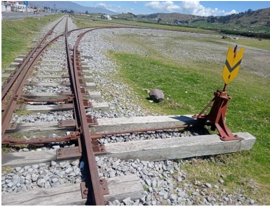
Vía ferroviaria de Colta
