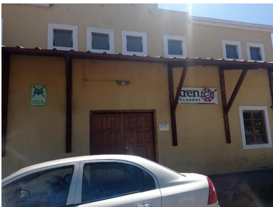
Estación ferroviaria de Colta
