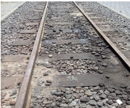
Vía ferroviaria de Alausí.
