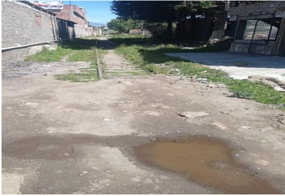
Vía ferroviaria de Colta
