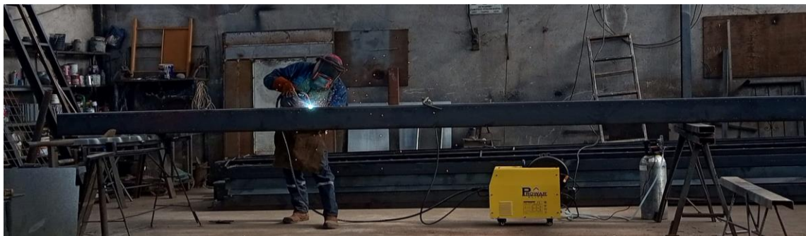
Ilustración 4-8: Operación de soldadura manual Realizado por: Quinllin H., 2024
