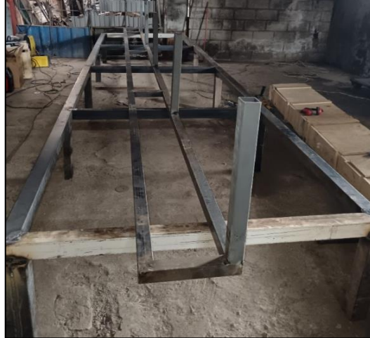
Ilustración 3-26: Colocación de soportes verticales y horizontales Realizado por: Quinllin H., 2024
