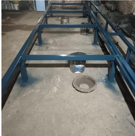
Ilustración 3-28: Capa de pintura en la estructura completa de las bases Realizado por: Quinllin H., 2024
