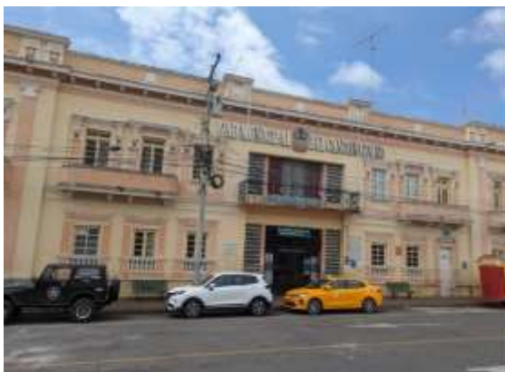
Ilustración 3-14: Fachada del edificio principal
