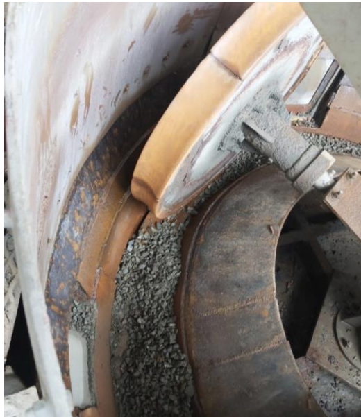
Ilustración 2-3: Vista interior del molino
