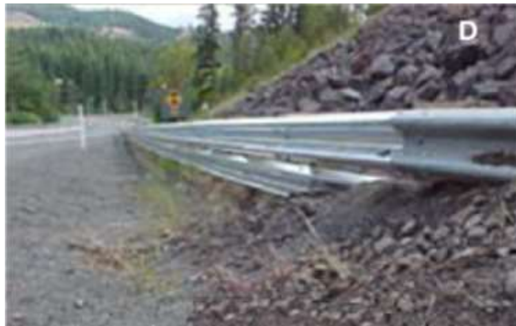
Ilustración 2-5: Terminal Empotrado en Talud.
