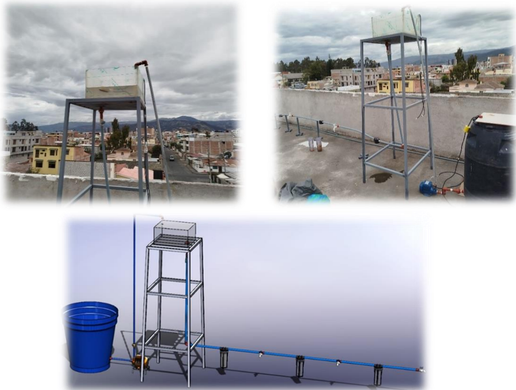
Ilustración 4-18: Construcción del prototipo de pruebas
